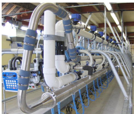
УСТАНОВКА ТРУБОПРОВОДОВ НАД ДОИЛЬНОЙ ЯМОЙ
